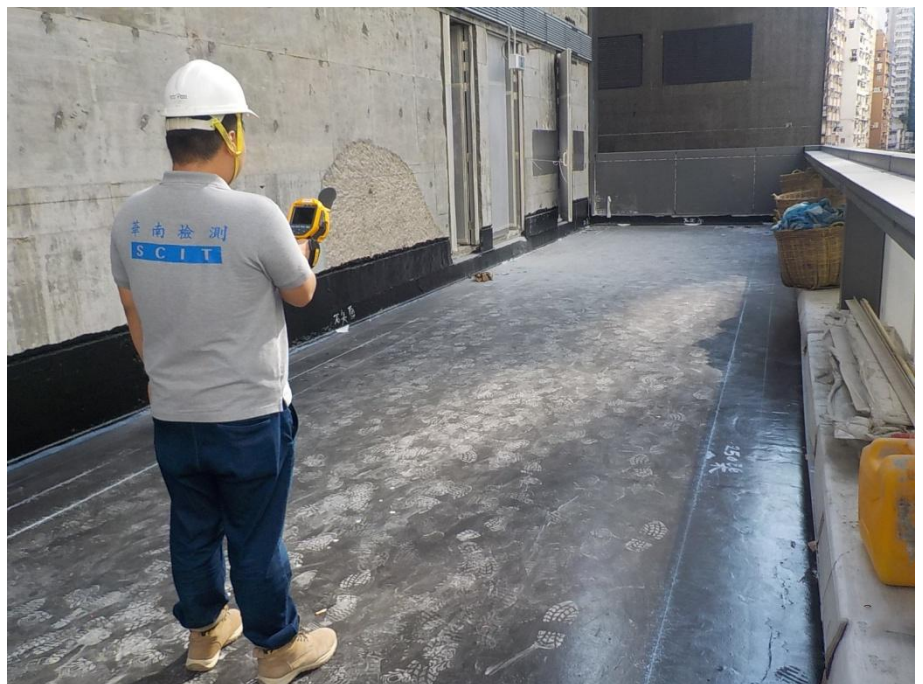
Infrared Scan for the Waterproofing Layer 防水層 紅外線掃描
